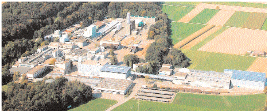
Das Areal der Papierfabrik Utzenstorf ohne (oben) und mit Gaskraftwerk (unten).
