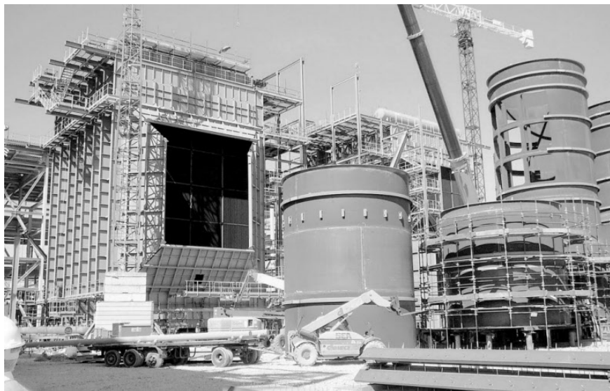
Die Baustelle in Livorno Ferraris: Links der Abheizkessel zur Erzeugung von Dampf , rechts die Kaminrohre.
