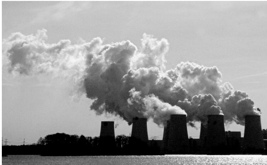
Die Kühltürme des Braunkohlekraftwerks Jaenschwalde in Südbrandenburg; Barbara Egger will verhindern, dass unter der Federführung der BKW eine solche «CO2-Schleuder» gebaut wird.
