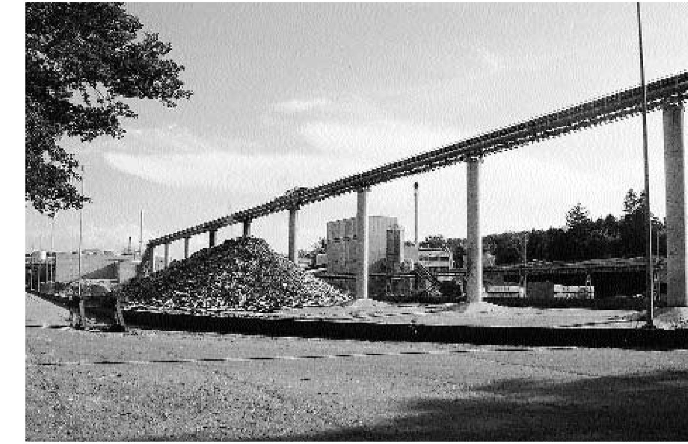
In diesem Bereich der Papierfabrik Utzenstorf soll bis 2010 das Gaskraftwerk der BKW gebaut werden.
