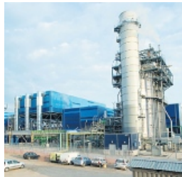
Gaskombikraftwerk mit Mehrheitsbeteiligung der Schweizer EGL im süditalienischen Sparisese. (Bild: pd)
