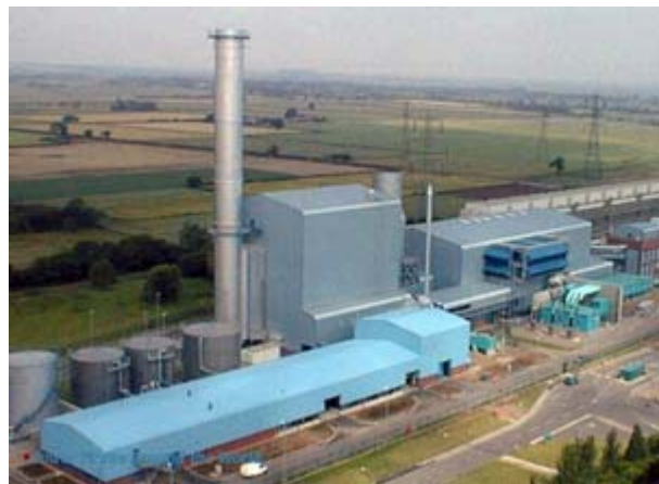
400-MW GuD-Kraftwerk, Nottinghamshire, UK, 1999
